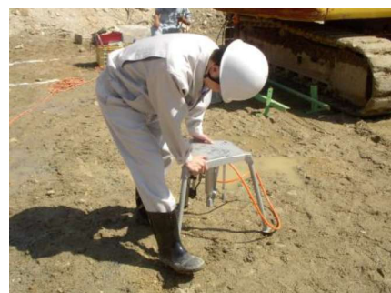
足掛け板を踏み、スパイクを貫入
